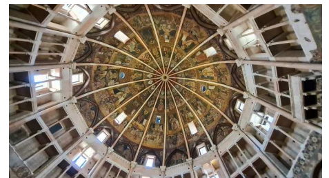
Deckengewölbe im Baptisterium in Parma
